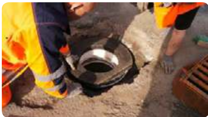
10 | Umístěte adaptér pro uliční vpust na vyrovnávací prstence.
