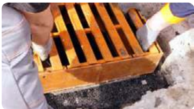
13 | Položte uliční vpust na adaptér a pevně přitiskněte pro dobré rozložení tmelící hmoty.
