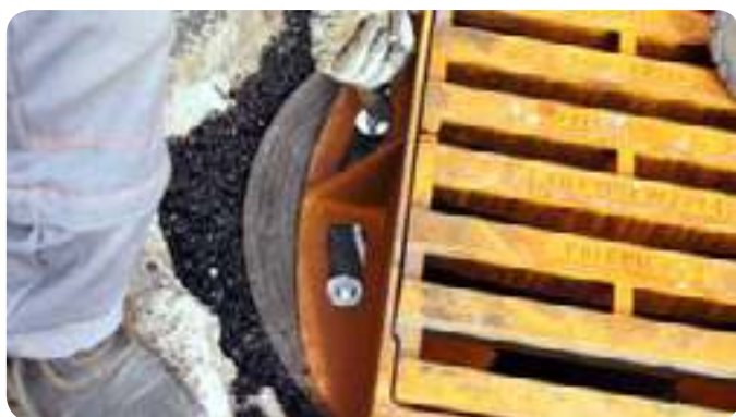
14 | Pomocí šroubů připevněte rám uliční vpusti k adaptéru, čímž zajistíte ochranu před posunutím.
