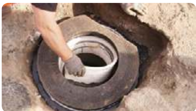
11 | Odstraňte bednění a zkontrolujte, jestli byly případné praskliny správně vyplněny.
