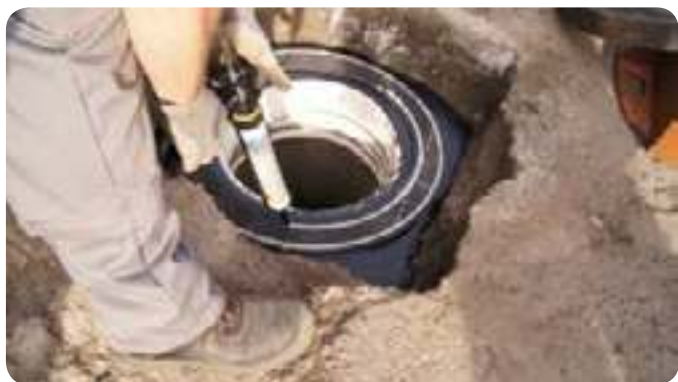
9 | Naneste polymerový tmel na další prvek vrchní části uliční vpusti.
